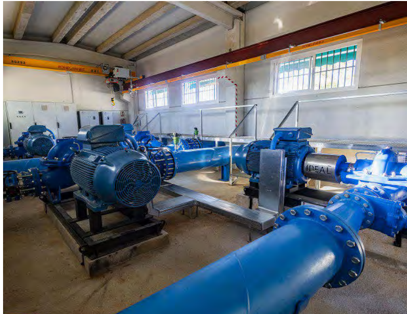
Nuevo sistema de tuberías instaladas el año pasado por la Comunidad de Regantes del Gasset. / RUEDA VILLAVEVERDE
