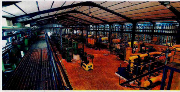
Instalaciones de la empresa pública de agua de la Costa del Sol Occidental
